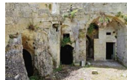
Chantier. Un ancien taudis creusé dans la roche, en cours de restauration
