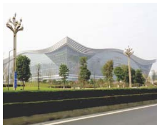
RECORD Le Global Center, plus grand bâtiment du monde sous un même toit.
