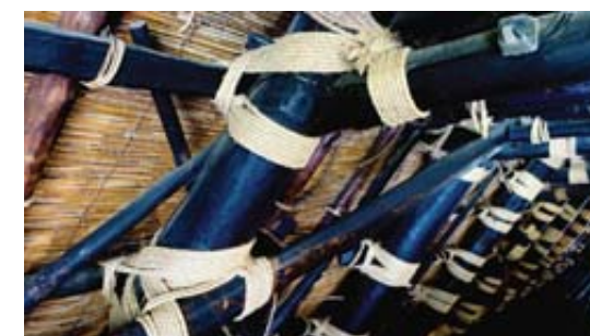
Poutrage. Des charpentes qui illustrent un savoir-faire ancestral.
