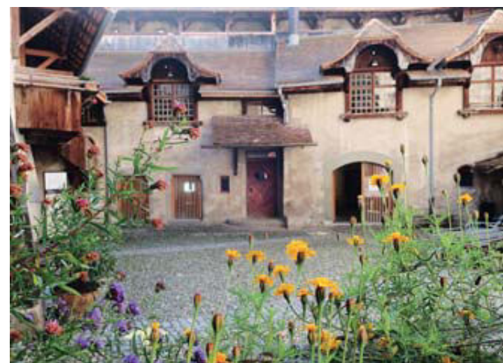
HABITAT Les cours intérieures confèrent au château une allure villageoise. BERNARD PICHON
